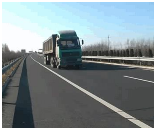
实体 工程 试验路
