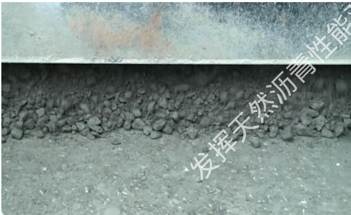
2. 螺旋两端料槽前方的卸荷口处，由于没有有效的遮挡，卸荷口处没有布料螺旋，造成粒料堆积，大粒料向下滚落于摊铺下层形成竖向离析，容易渗水，形成早期损坏。
